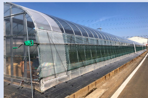
実使用現場の例 ハウス側面に使用 (埼玉県内小松菜生産者)
